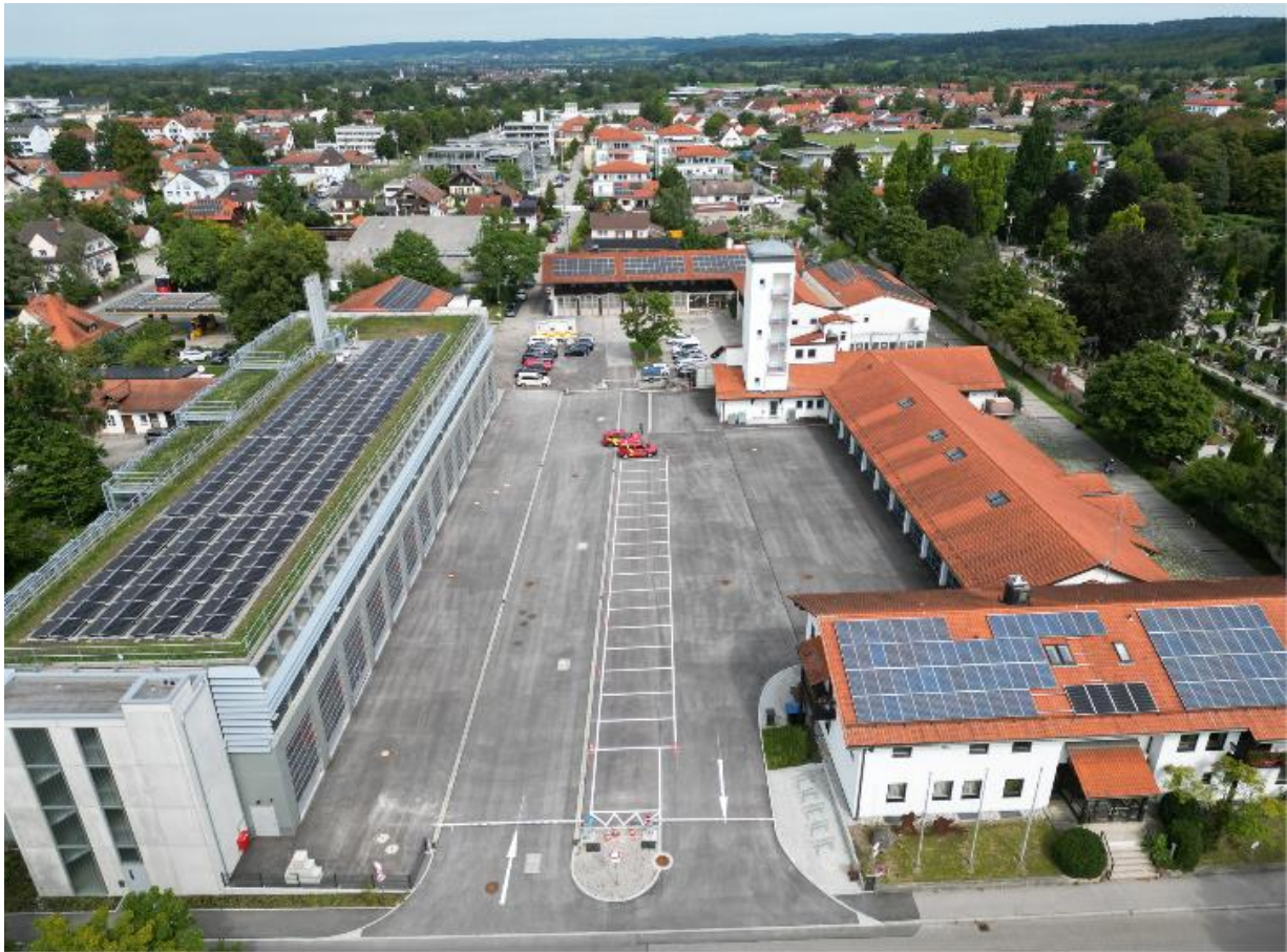
Das neue Parkhaus mit Heizzentrale sowie Einstellhallen für unsere Feuerwehr und dem BRK (Foto: Stadtwerke)
